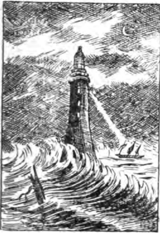
Fig. 4. Latarnia morska Eddystone.
