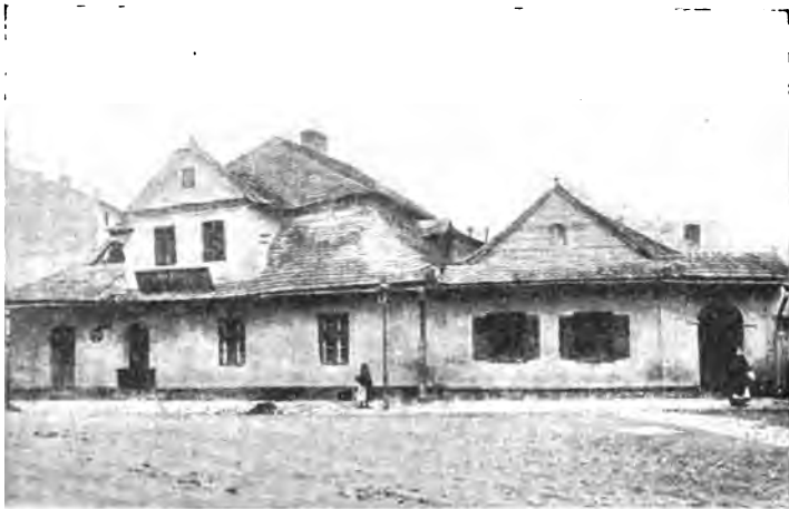
Fig. 11. Ostatnie stare domy na Kleparzu.
