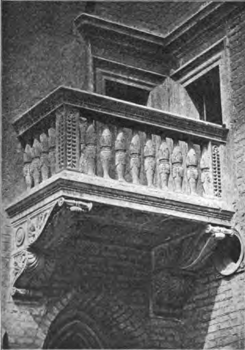
Ganek z r. 1520 na piętrze wieży kościoła N. P. Maryi w Krakowie.
