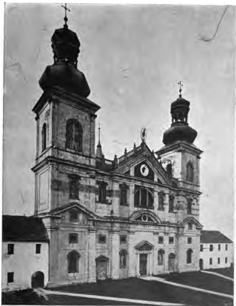
Widok fasady kościoła.
