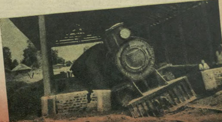
PONIZEJ: Ta lokomotywa po prostu zapadła się w ziemię w jedną z niezliczonych szczelin, które spowodowało trzęsienie ziemi w Assamie 15 sierpnia 1950
