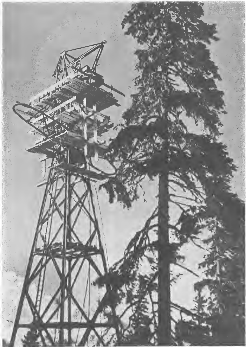
TECHNIKA I PRZYRODA. Śmiała konstrukcja żelazna wieży harmonizuje doskonale z wspaniałymi stuletnimi świerkami. Na wieży widzimy rusztowania montażowe. Fundamenta tej wieży zostały o kilkanaście metrów przesunięte dla zachowania dwóch wspaniałych świerków widocznych na zdjęciu.
