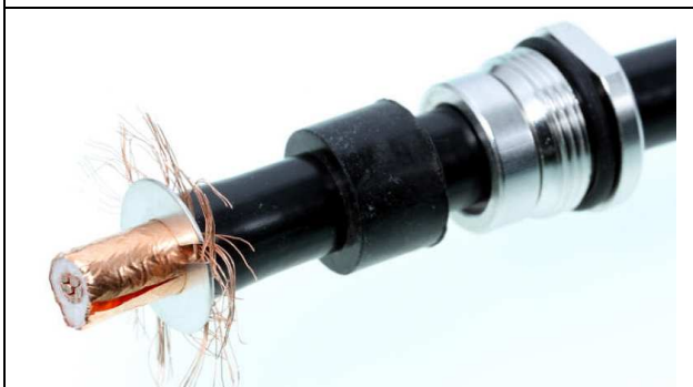
Rys. 6.8c. Założenie pierścienia dociskowego
