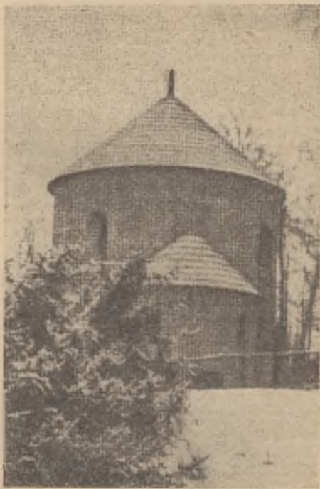
Rotunda po przebudowie
