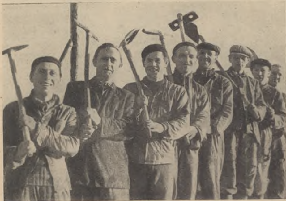
Betoniarzka brygada towarzysza Koči-go z budowli osiedla Karwina-Stalingrad. Brygada ta wykonała swój plan w 315%. Jest to najlepsza betoniarzka brygada w powiecie Karwina na Śląsku
