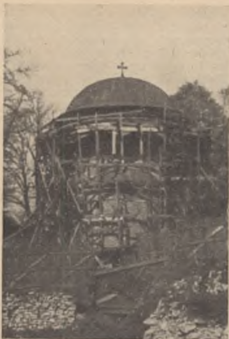
Rotunda przed przebudową
