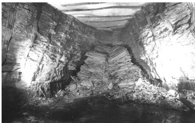
Rys. 6. Zawał stropu bezpośredniego na skutek działania znacznych obciążeń poziomych w kopalni White Pine, USA [1]
