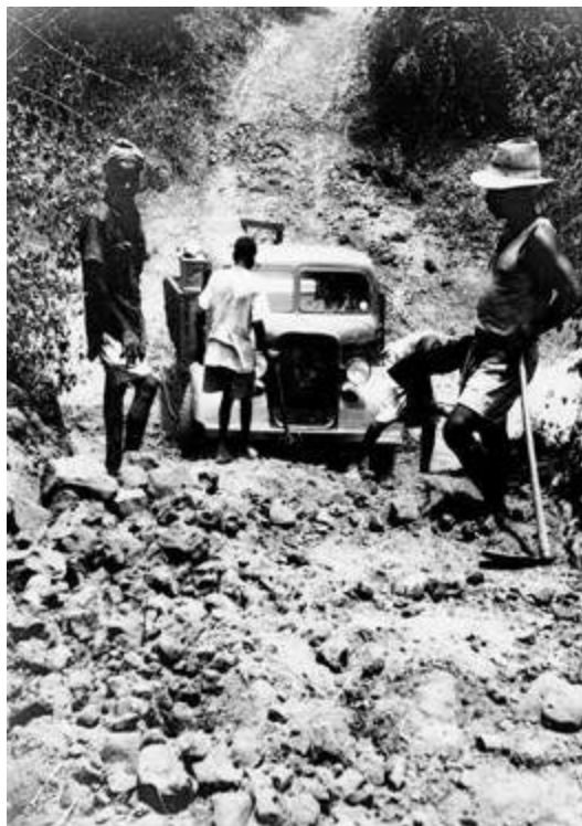
Budowa dróg w latach czterdziestych i pięćdziesiątych
