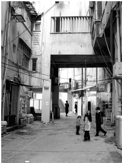
Typowy dla Bnei Braku zaułek; domy z poprowadzoną na zewnątrz instalacją elektryczną, butlami gazowymi i silnikami klimatyzatorów
