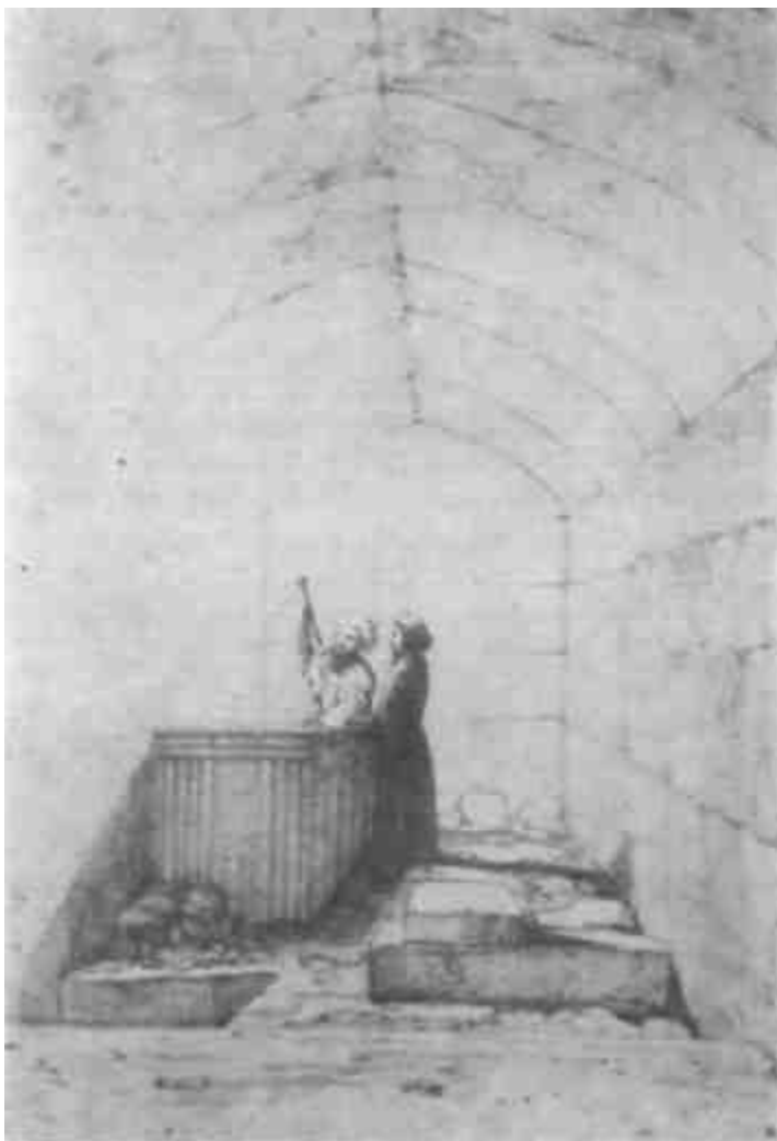
86. Komora grobowa Trzeciej Piramidy, z widocznym sklepionym sufitem i sarkofagiem bazaltowym
