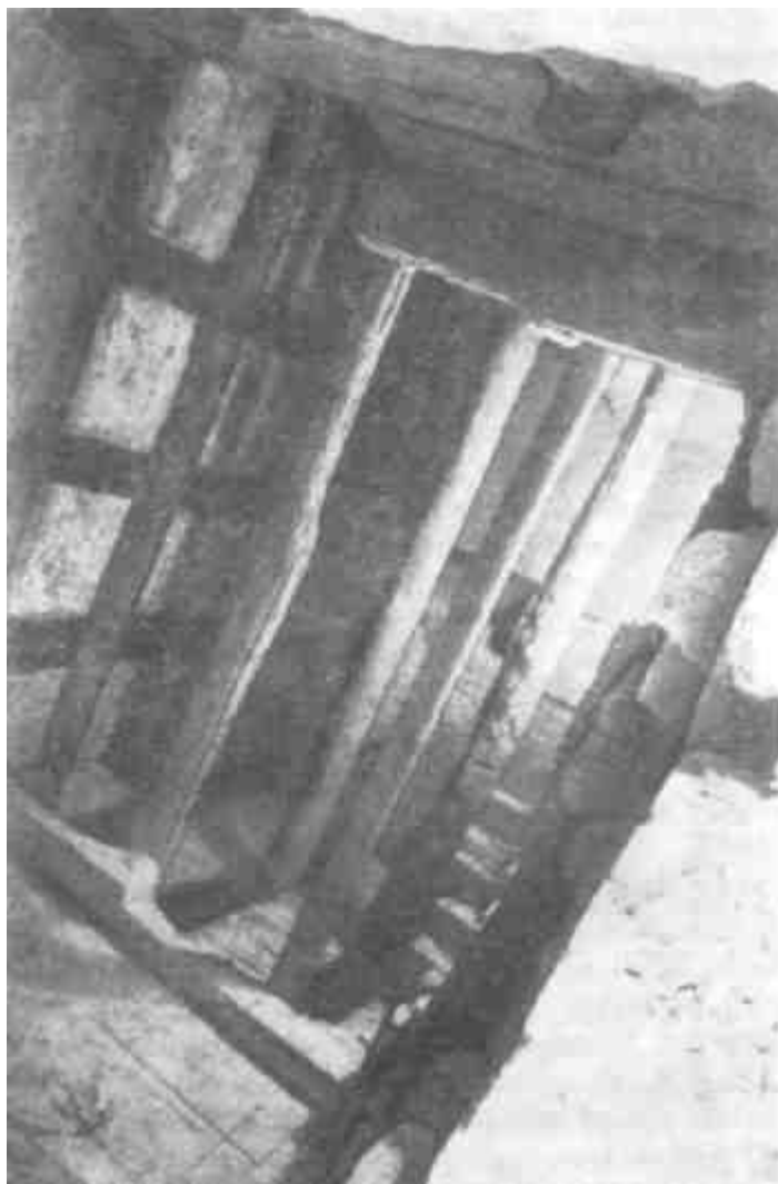
54. Belki cedrowe w górnej komorze Południowej (Łamanej) Piramidy Snofru w Dahszur
