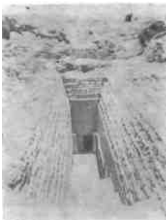
20. Widok zewnętrzny wejścia do Niedokończonej Piramidy w Sakkara
