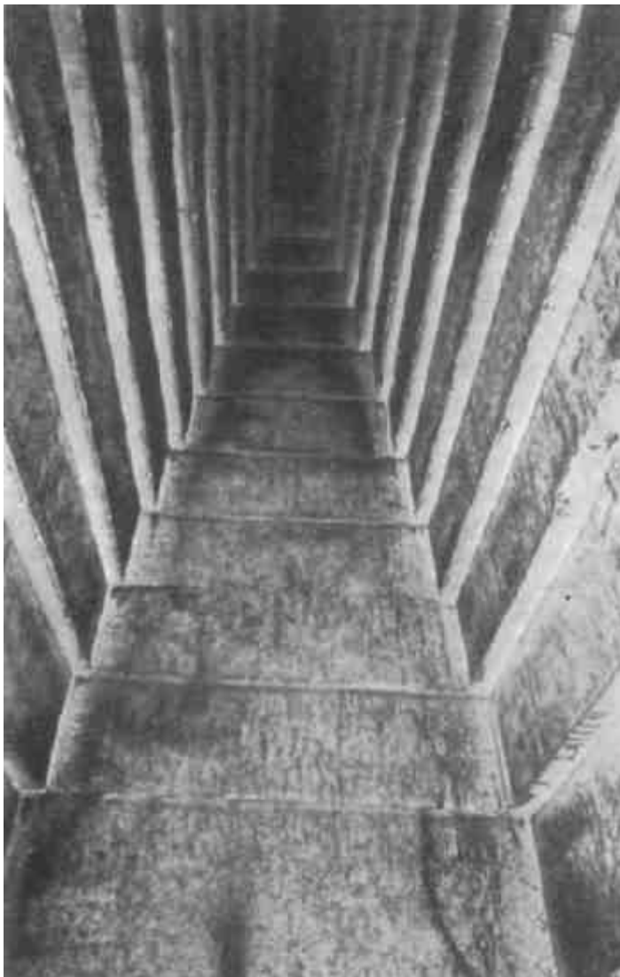
58. Wspornikowy strop w Północnej Piramidzie Snofru w Dahszur
