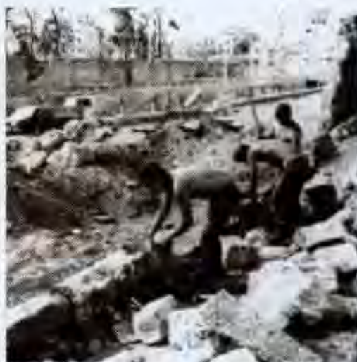
Żołnierze-budowniczowie w Libanie: naprawa muru ambasady francuskiej
