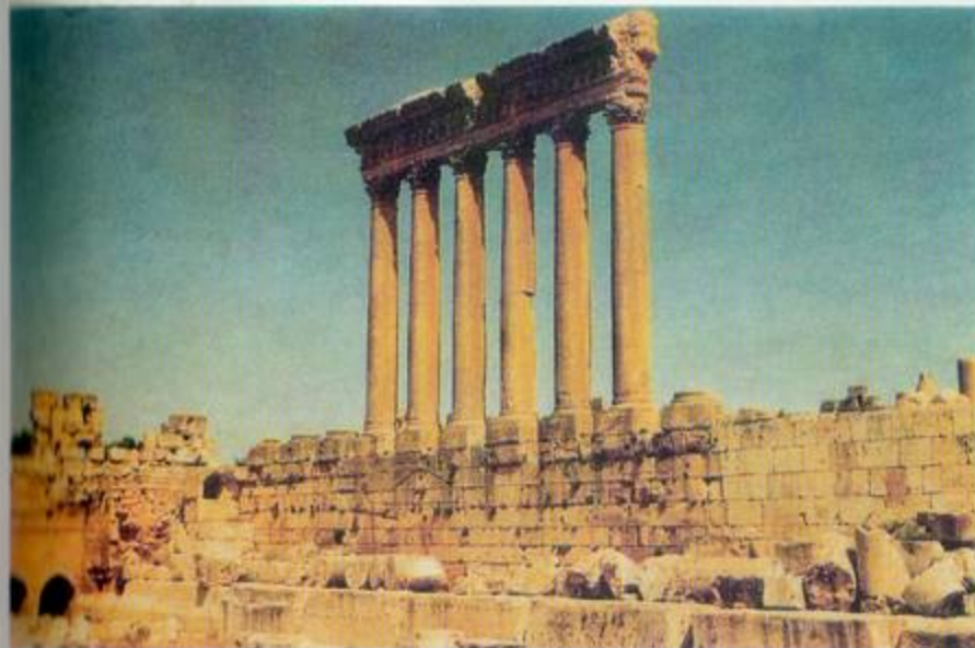
1. Świątynia Jowisza w Baalbek w Libanie. Widoczna jest dolna ściana zbudowana z trzystutonowych monolitów
