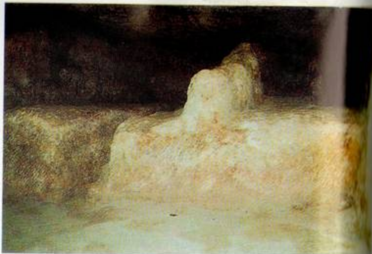
33. Komora Podziemna w Wielkiej Piramidzie. Wykute w kamieniu elementy są silnie zerodowane pod wpływem działania wody deszczowej
