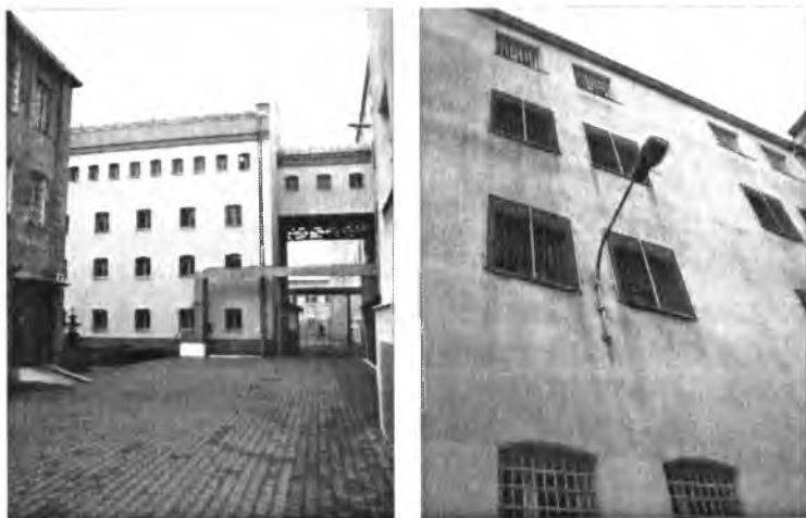
Była katownia bezpieki widziana od więziennego podwórza
