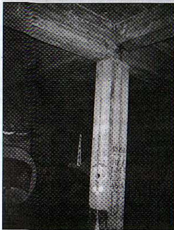
Jedynie dostępne dziś pomieszczenie we wnętrzu wielkiego bunkra. Czy są jeszcze inne?
