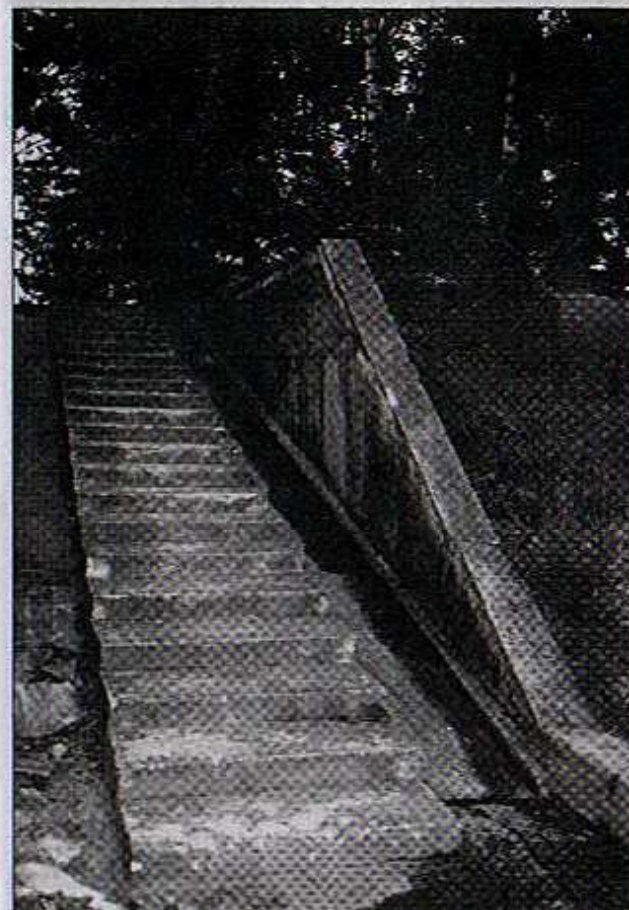
Prowadzące donikąd betonowe schody. Po ich obydwu stronach widać płaszczyzny do sprowadzania wózków.
