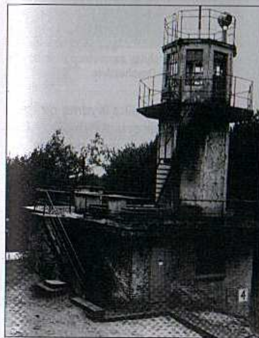
Bunkier startowy przy płycie z wielką lufą. Po wojnie nadbudowano na nim wieżyczkę.
