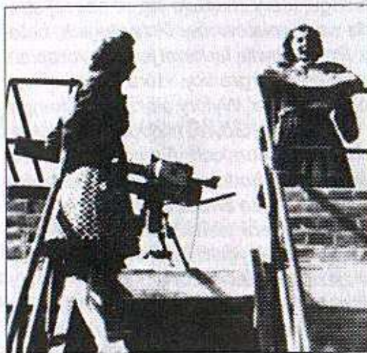
Stanowisko obserwacyjne z kinoteodolitem. Z niego obserwowano zrzuty bomb, a później starty rakiet.
