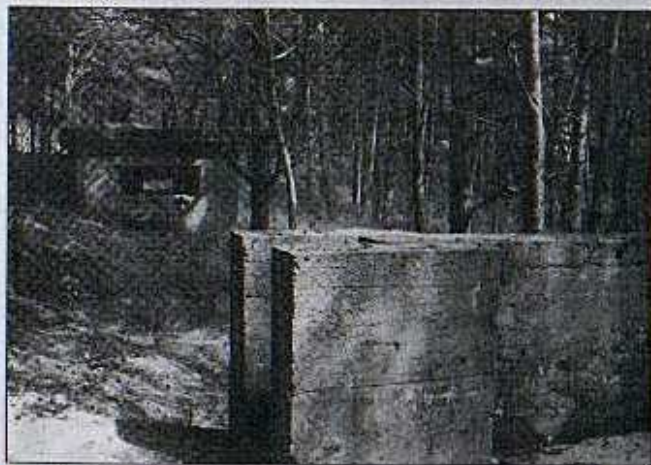
Fundament i bunkier startowy pierwszej wyrzutni ustawionej w 1941 roku na terenie Stacji Doświadczalnej Łeba.
