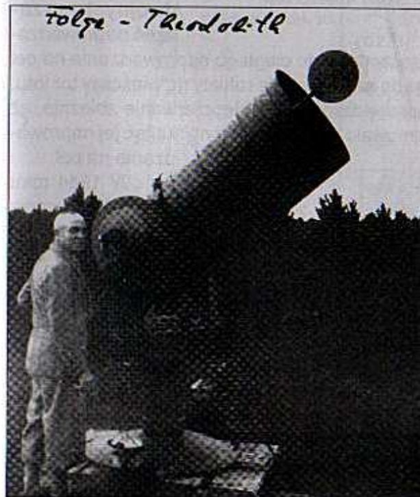
Fototeodolit służący do naprowadzania i kierowania raketami Rheintochter .
