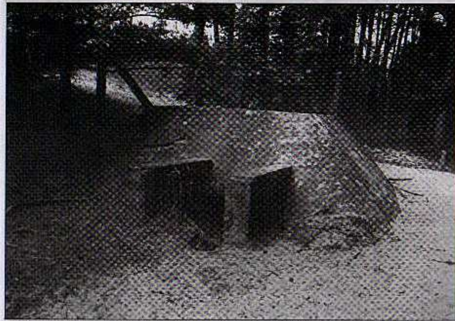
Fundamenty po urządzeniu radiolokacyjnym przed wejściem na teren wyrzutni.
