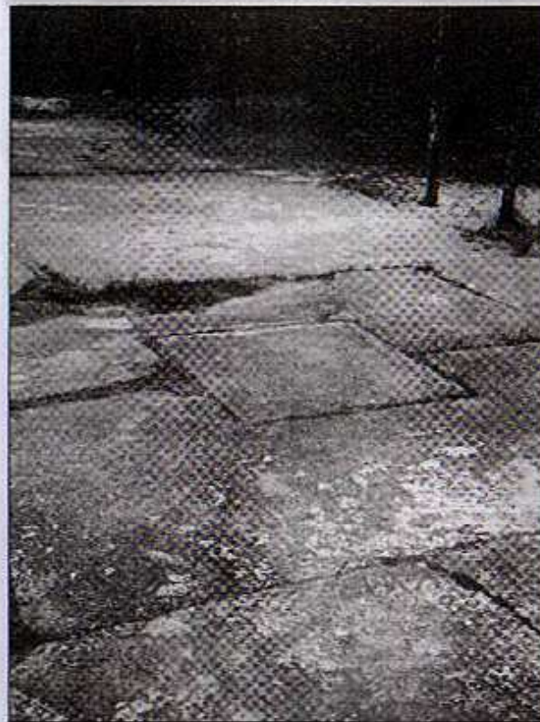
Na betonowej powierzchni placu wyraźnie rysuje się kształt filara. Czy podtrzymuje strop bunkra?
