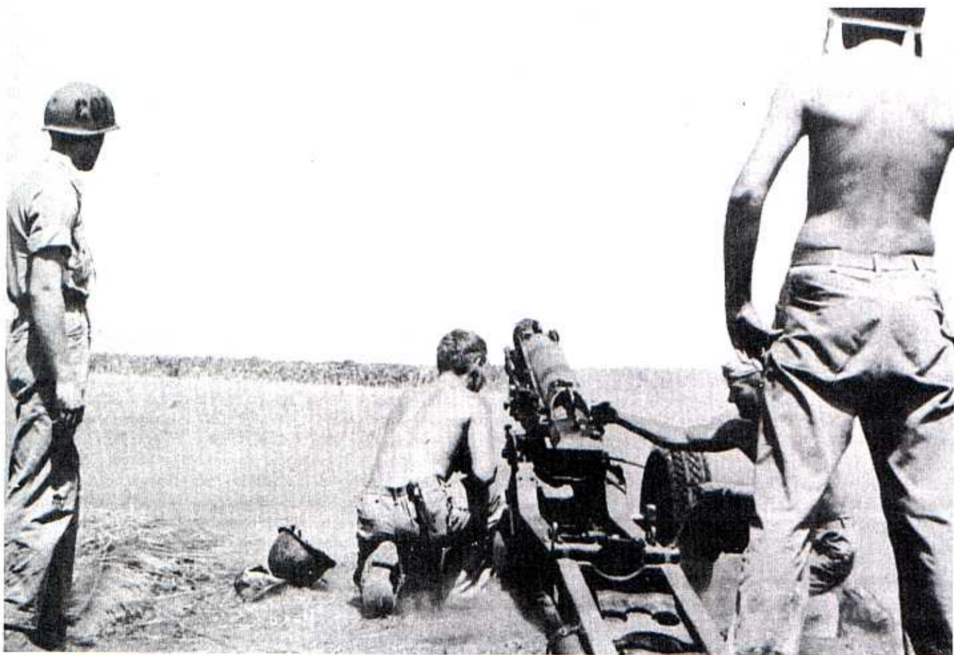
Amerykańska przenośna haubica M1A1 kalibru 75 mm z 1. Dywizji Piechoty Morskiej, sierpień 1942 roku. A Marine 75 mm M1A1 pack-howitzer in action. August 1942. [U.S.M.C. Official]
