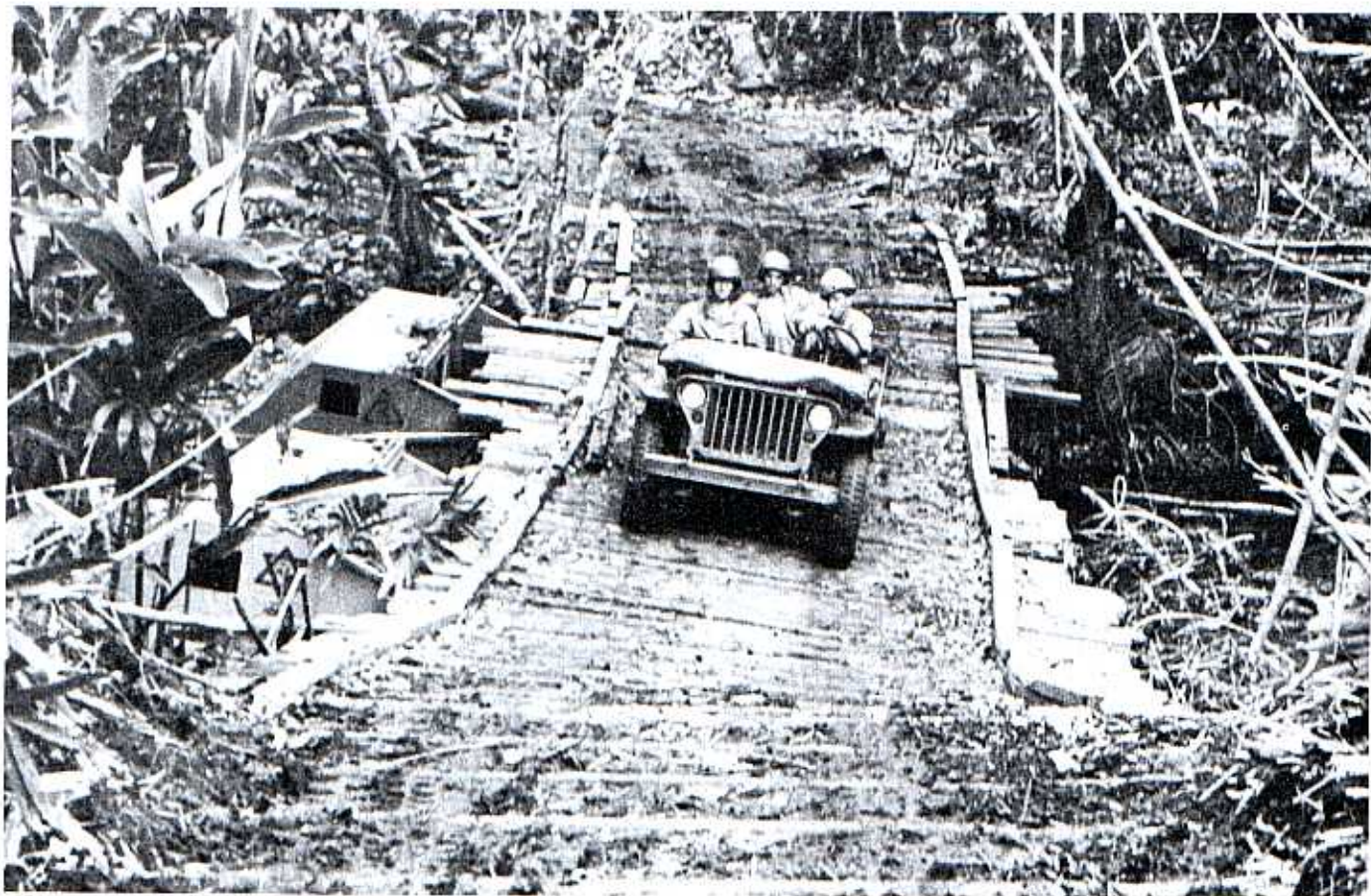
Most na rzece Tenaru ustawiony na dwóch amfibiach typu LVT-1, na zdjęciu Jeep z 1. Dywizji Piechoty Morskiej. A Jeep of the 1st Marine Division crossing River Tenaru on a bridge. Two amphibian tractors LVT-1 were used to support the flooring. [U.S.M.C. Official]
