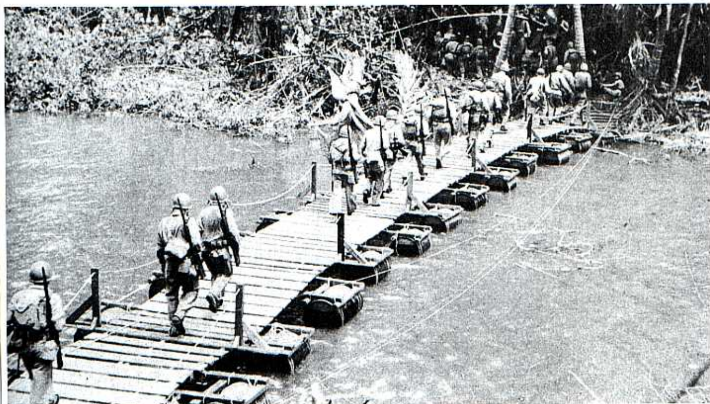
Most pontonowy, zbudowany z wykorzystaniem pustych beczek, przez rzekę Matanikau, listopad 1942 roku. A fuel-drum ponton foot-bridge across Matanikau River, November 1942. [U.S.M.C. Officials]
