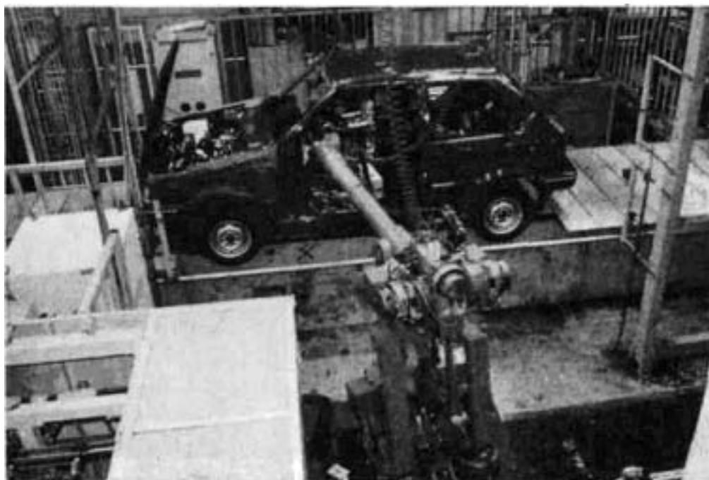
Ryc. 9.1 Robot przemysłowy w fabryce samochodów Nissan w Jokohamie
