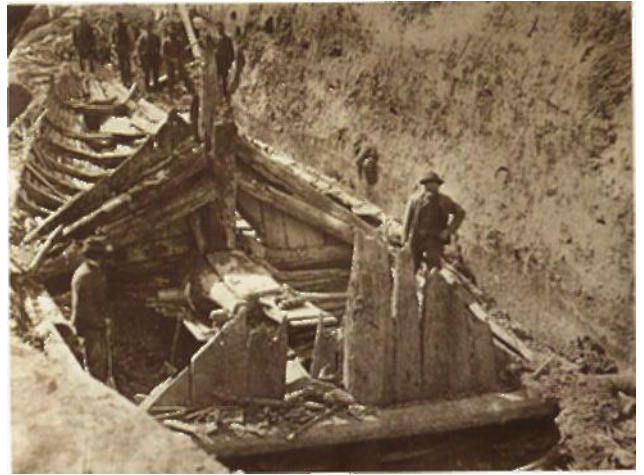
Lekkie poszycie statku wykonano z drewna dębowego, cięższy maszt zrobiony został z jednego pnia sosny
