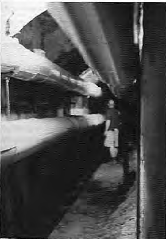
Fragment podziemi – piwnic zakładów Dall.
