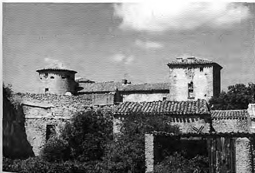
Zamek Rennes-le-Chateau, jedno z miejsc, gdzie szukano Graala. (fot. M. Banaś).
