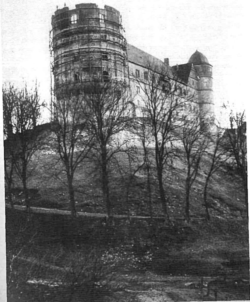
Wewelsburg podczas prac renowacyjnych prowadzonych przez SS w 1933r.
