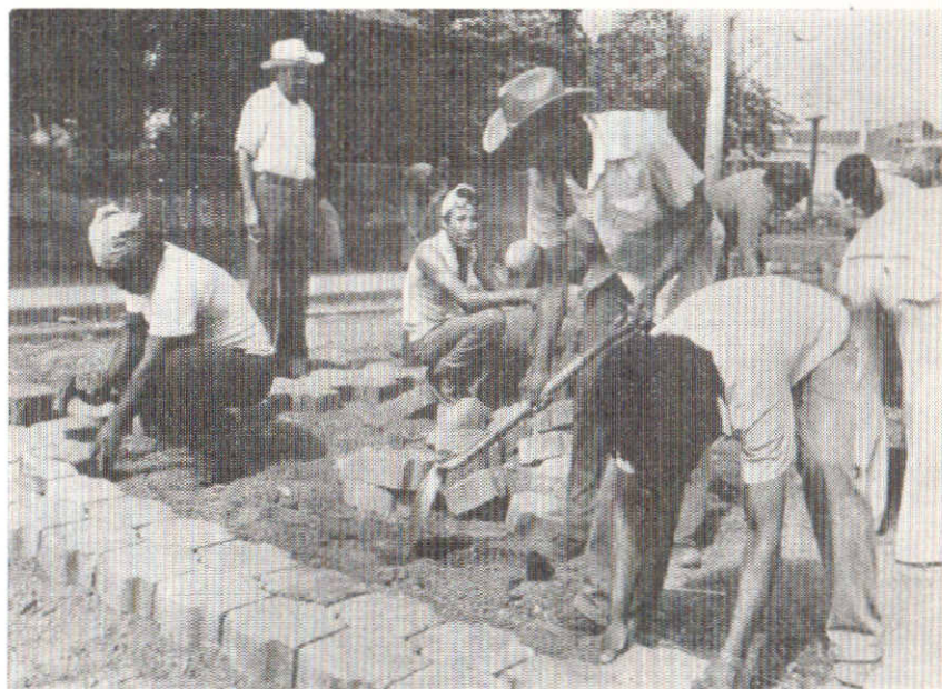
Managua — odbudowa zniszczonych ulic
