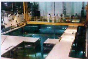
Basen na paliwo wypalone (6m 3 /rocznie) Spent fuel pit (6 m 3 /year)
