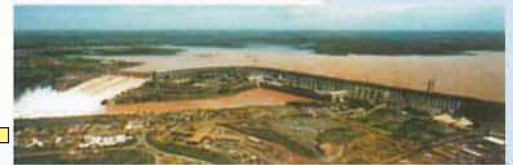
Elektrownia wodna Itaipu (Brazylia) Itaipu hydroelectric power plant (Brazil) 13.000 MW
