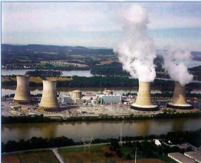
Widok na elektrownię
