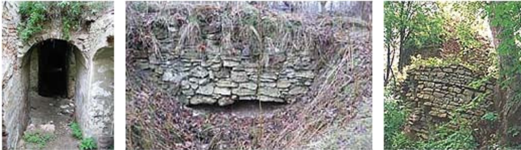
Próbki polskiego budownictwa "bagiennego" - Chrzelice, Świerklaniec i Czarny Bór
