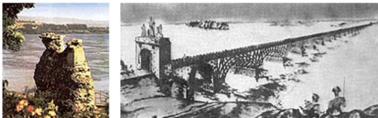
Szczątki mostu i jego "papierowa" rekonstrukcja
