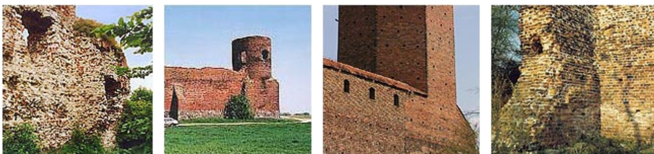
Przykłady budownictwa ceglanego Kazimierza III - Bochońnica, Koło, Łęczycza i Złotoria
