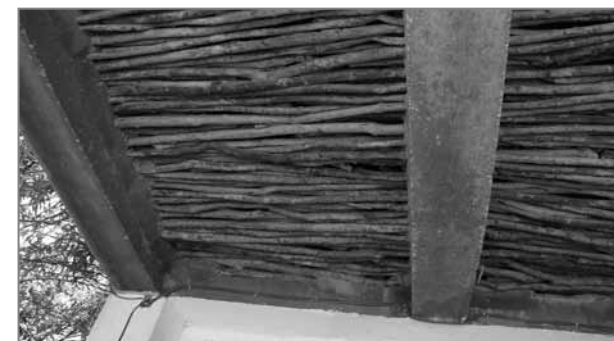
Strop wykonany z gałęzi i betonowych belek w Campe-ment „Gite Femme Dogon” w Sandze.
