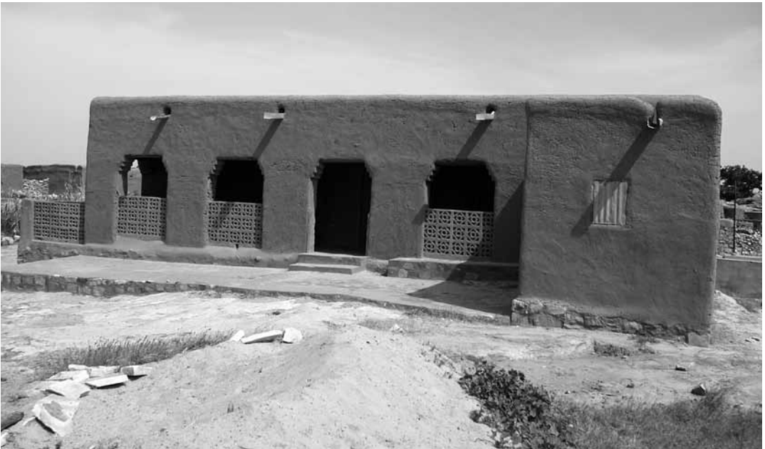
Budynek francuskiej misji etnologicznej w Ogo1-Dah.
