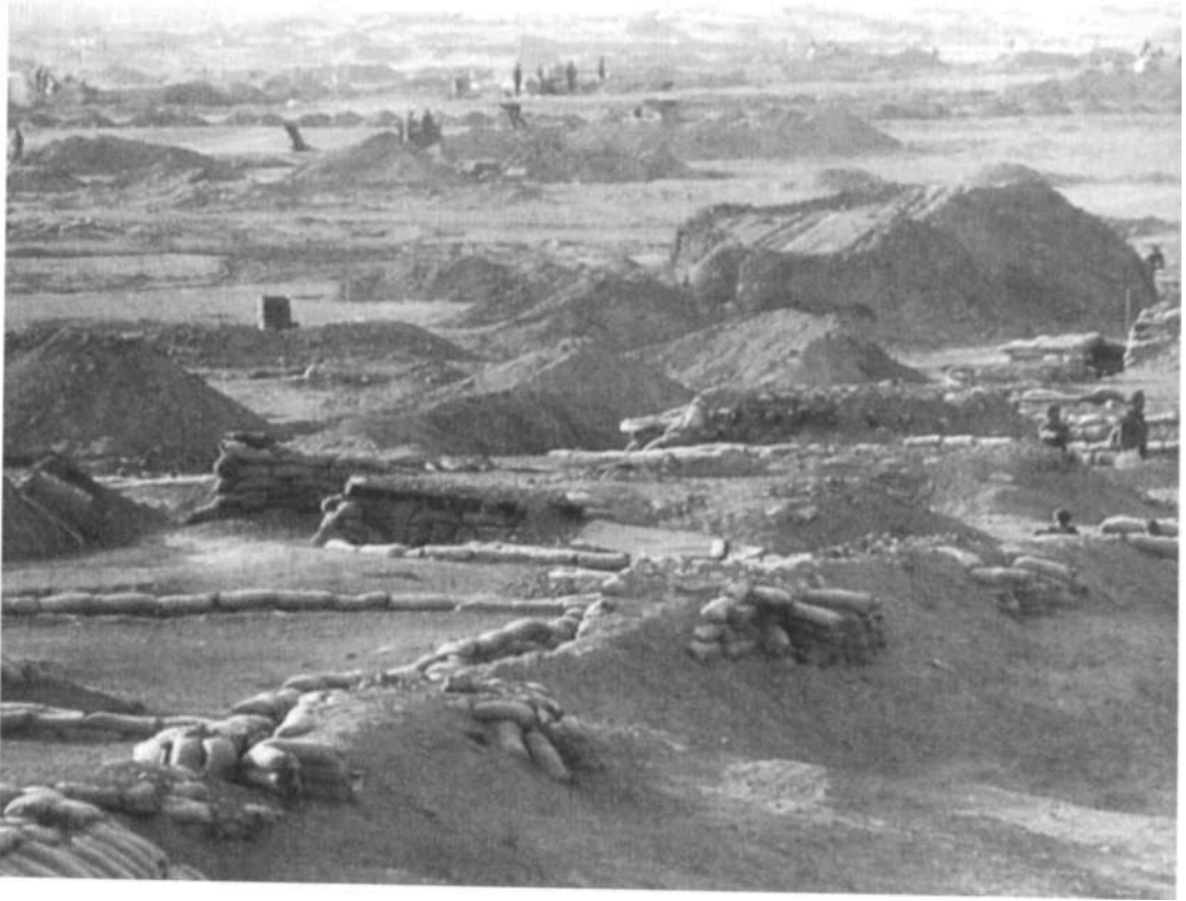
Irackie umocnienia w okolicach Basry.
