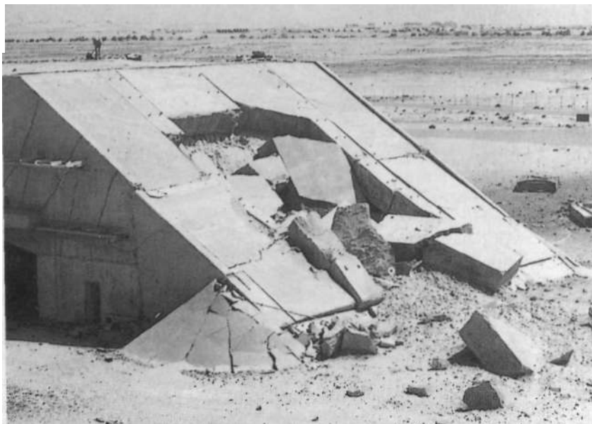
Zniszczony ira schronohangar (RAF)
