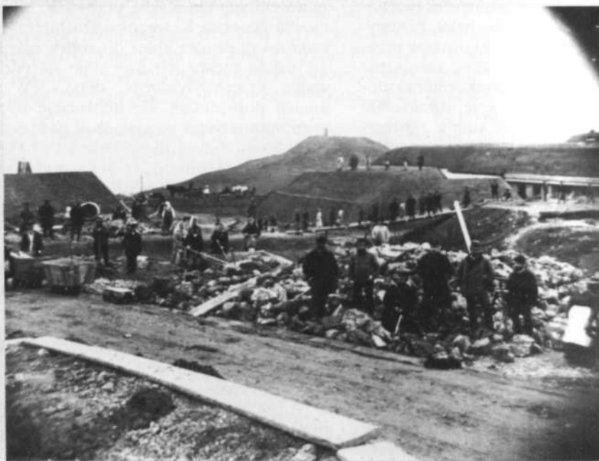
Budowa fortu Duńkowiczki
