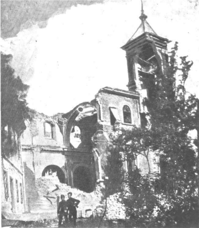
Zniszczony kościół w Gorlicach po przejściu frontu
