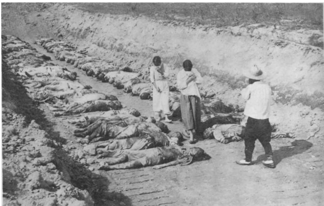
W rejonach z których wyparło komunistów znajdowano liczne groby pomordowanych "elementów obcych klasowo". Na zdjęciu identyfikacja ciał przygotowanych do pochowania.
