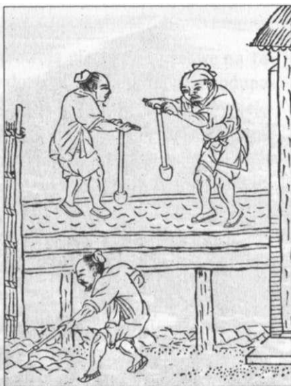
Rycina przedstawia ubijanie ziemi przy budowie chińskich murów.
