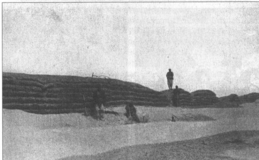
Robotnicy Aurela Steina podczas przerwy przy odkopywaniu z piasków pustyni fragmentu murów Han. Zwraca uwagę warstwowość muru, zbudowanego z kolejnych pokładów gałązek i sitowia.
