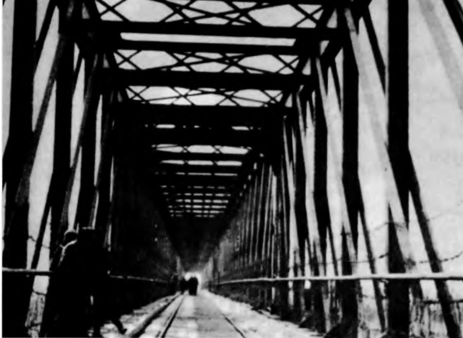
Most kolejowy na Mozie w pobliżu Gennepe.
