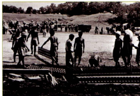
Jeszcze przed rozpoczęciem operacji desantowej opracowano technologię szybkiej budowy lotnisk połowych, w której wykorzystywano łączące się ze sobą prefabrykowane metalowe płyty podłoża. Na zdjęciu, wykonanym w środkowej fazie walk o Guadalcanal, rdzemi mieszkańcy wyspy pomagają w budowie lotniska Henderson Field.
