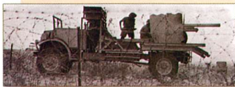
31 V 1942 r. Zdjęcie wykonane w pobliżu Tobruku, widać na nim przeciwpancerną armatę 6-pdr zamontowaną na podwoziu ciężarówki.
