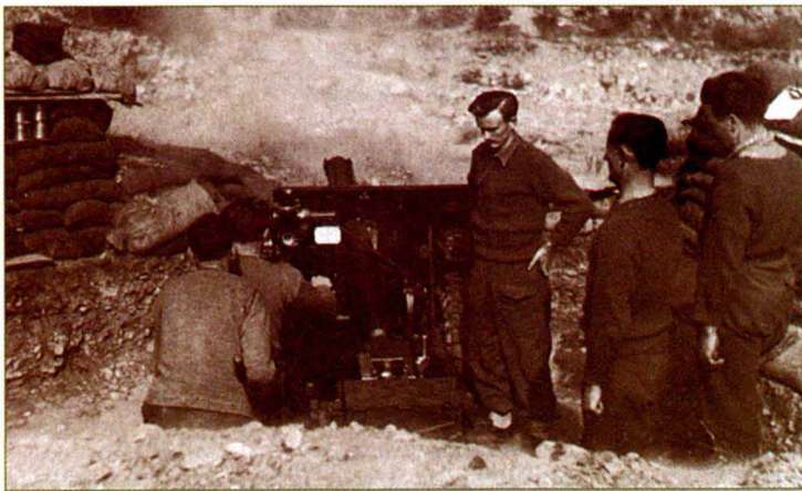
Eksperymentalna haubica 95 mm w trakcie testów bojowych we Włoszech. Broń, skonstruowana przy wykorzystaniu części istniejących wcześniej armat, nie znalazła uznania w oczach żołnierzy, nigdy nie wprowadzono jej w większej liczbie.
