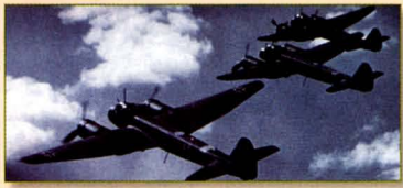
Ju 88A-4 wyposażone w radionamierniki EZ-6 (jasne kółka na górze kadłuba to ich pokrywy).
