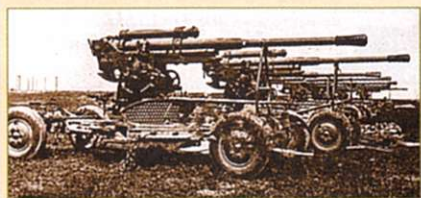
Armata przeciwlotnicza 85 mm wz. 1939 w położeniu marszowym.
