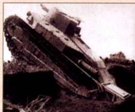
Zaletą czołgu „89” była możliwość pokonywania takich przeszkód. Pomagał w tym dodany z tyłu „ogon”.
