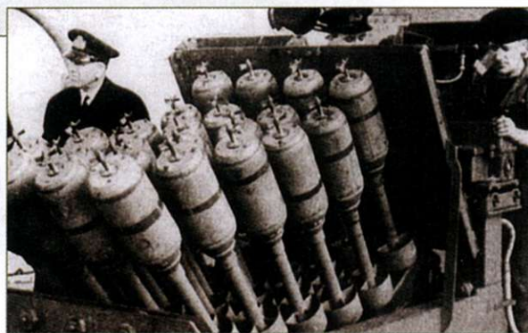
Rakietowy brytyjski miotacz bomb głębinowych „Hedgehog”.
