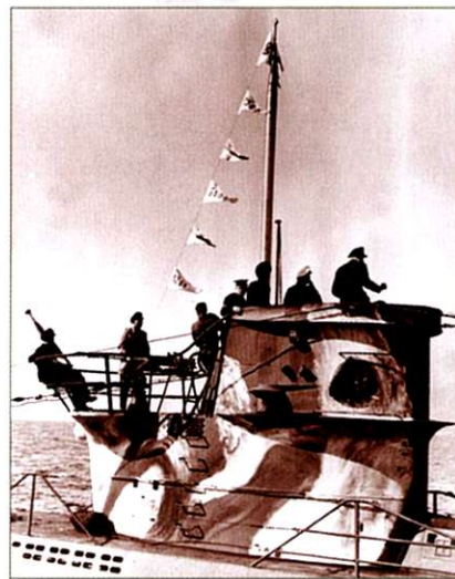
Kiosk niemieckiego okrętu podwodnego wracającego do bazy z patrolu bojowego. Chorągiewki wywieszone na peryskopie oznaczają zatopione statki wroga, jest na nich podana ich przybliżona wyporność. Warto zwrócić uwagę na malowanie kiosku, utrudniające dostrzeżenie wynurzonego U-Boota.
