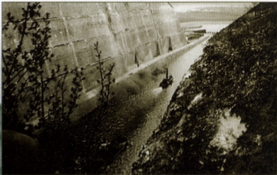
Kanał Alberta, przy którym znajdowała się twierdza Eben-Emael. Widoczna jest niemal pionowa ściana fortecy.
