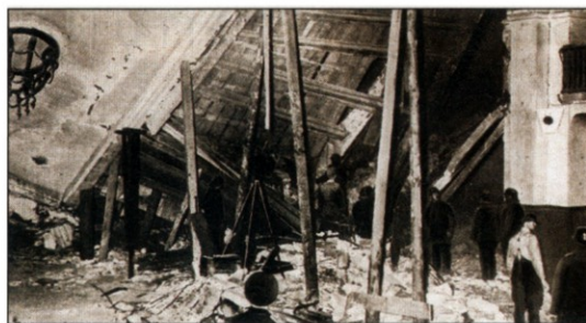
Wnętrze piwiarni po wybuchu bomby, widoczny jest częściowo zawalony strop sali.
