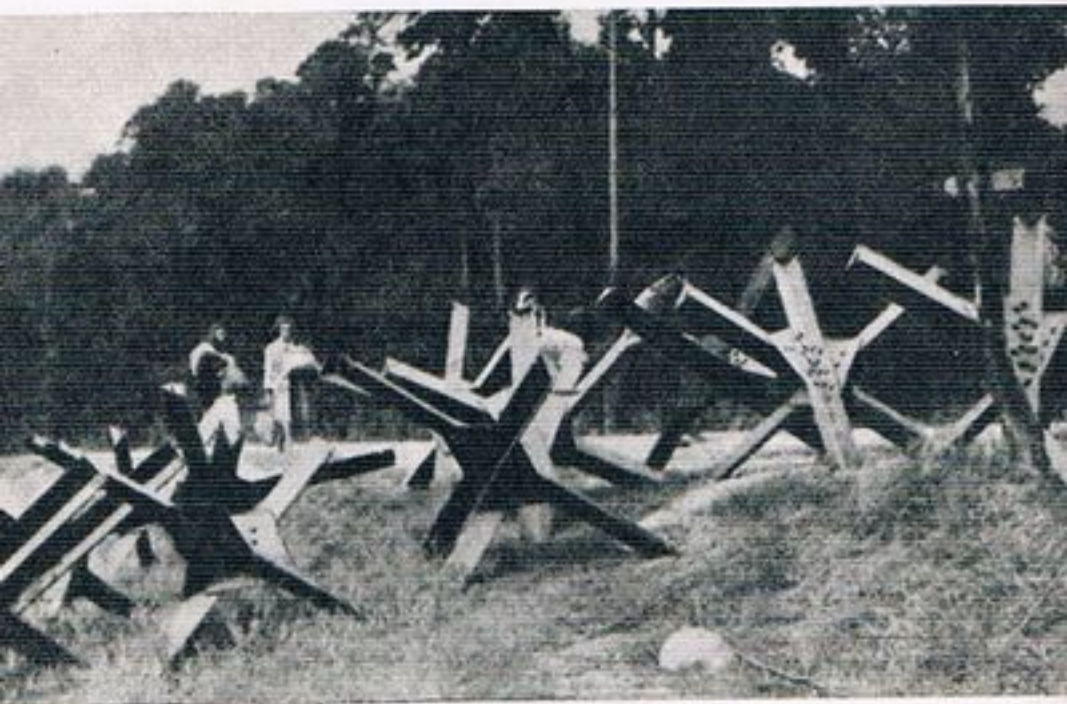
Niemieckie zapory przeciwpancerne na przedpolach Pragi
