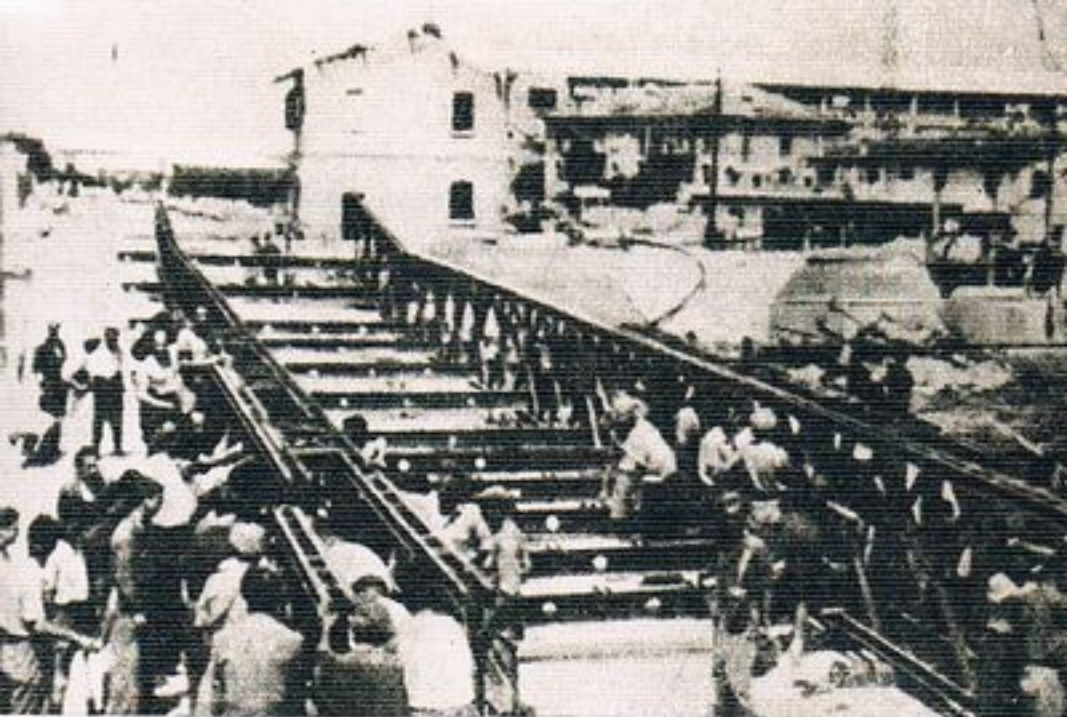
Budowa mostu w Senigallii
