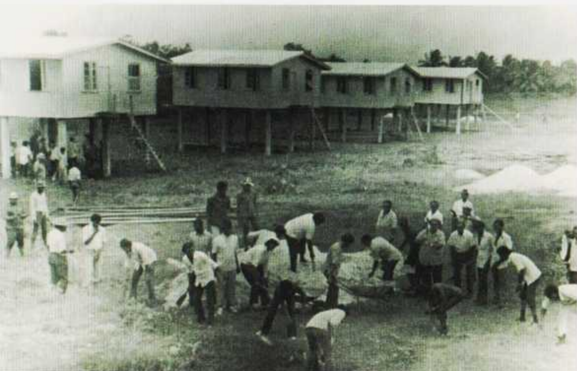
Budowa osiedla Scottsburg Housing Scheme, stworzonego przez kooperatywę powstałą z inicjatywy Josepha Scotta (lata 70.)
