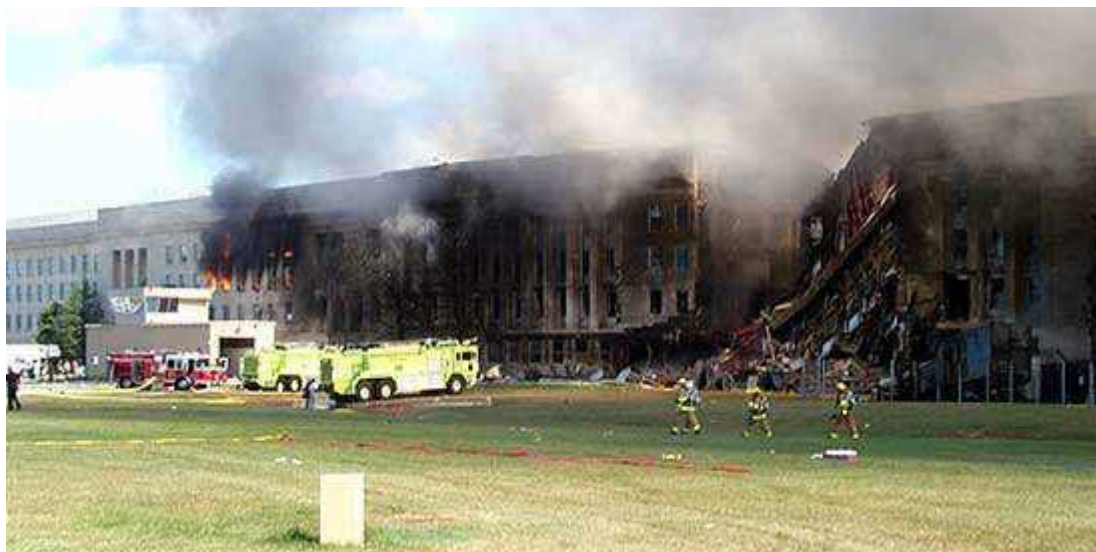
Rys. 3: Widać wyraźnie, że część budynku, które powinno zniszczyć uderzenie skrzydeł samolotu, nie została naruszona. Jak to możliwe? Nie widać tu również jakichkolwiek szczątków samolotu, ciał zabitych. Nie został zniszczony nawet trawnik. Czy muszę Wam mówić, co to oznacza? A może macie w sobie tyle odwagi, aby domyślić się „zakazanej prawdy”?
