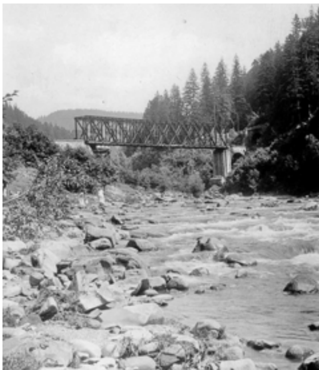
Wiadukt kolejowy nad Prutem – z lewej Jaremcze, z prawej tunel i Worochta.
