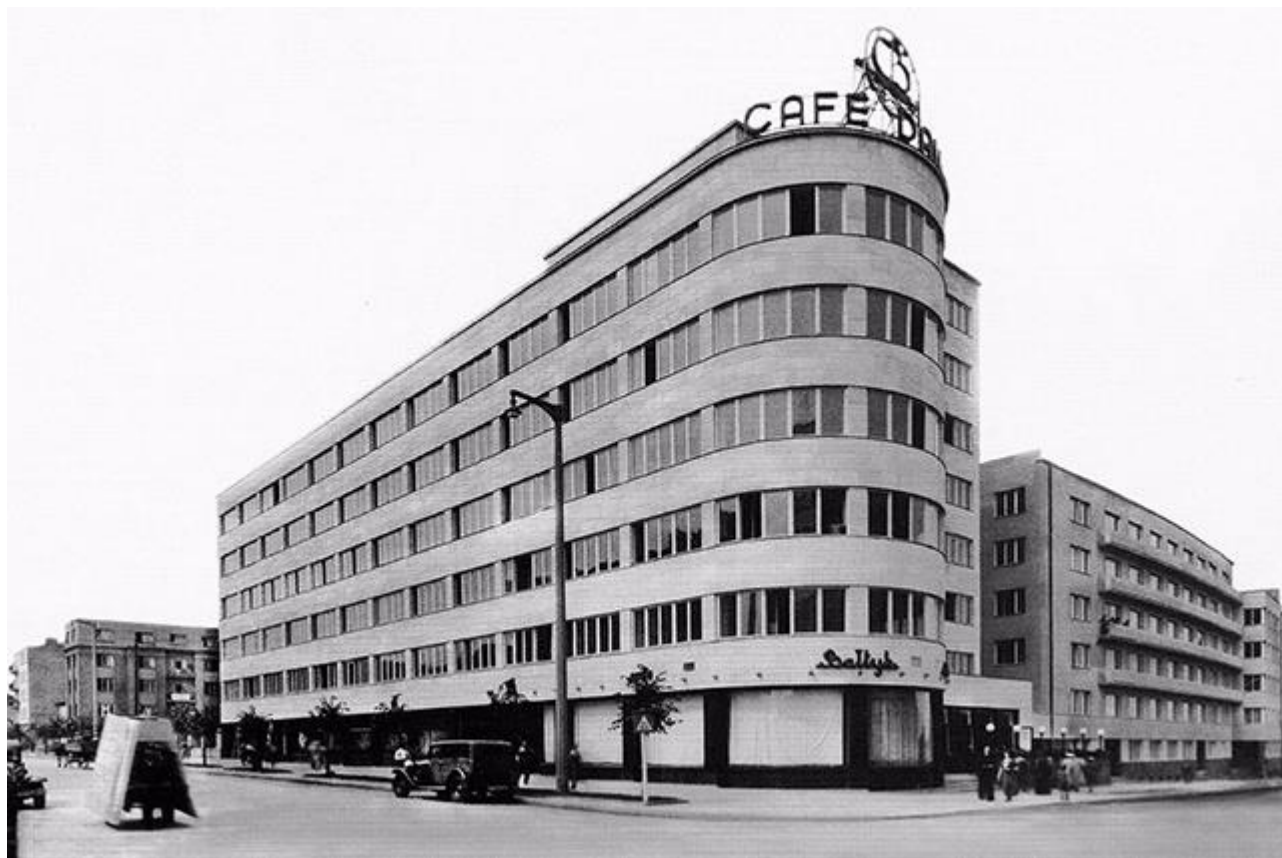
Budynek Zakładu Ubezpieczeń Społecznych. Na parterze Cafe Bałtyk.
