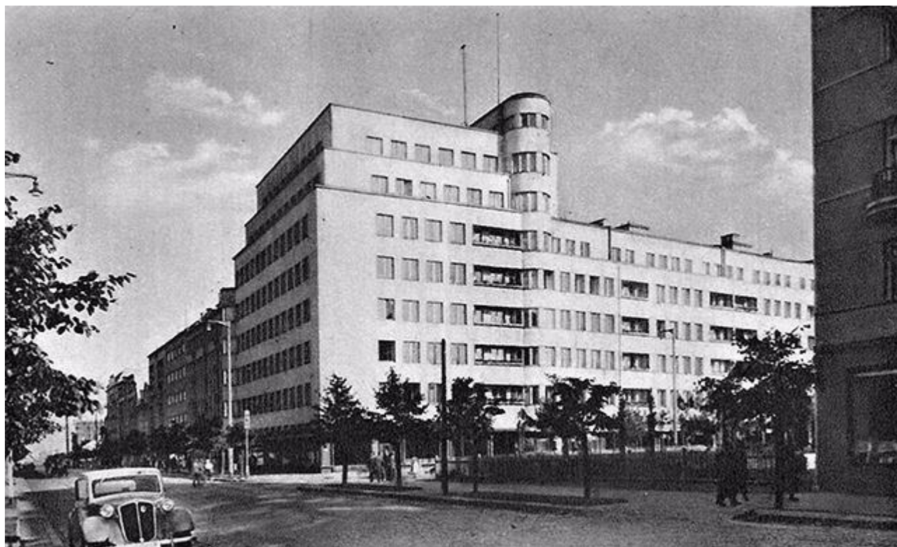
Budynek Funduszu Emerytalnego Pracowników Banku Gospodarstwa Krajowego (największy kubaturowo gmach mieszkalny międzywojennej Gdyni). Pod tym adresem wcześniej działała Czarodziejka.
