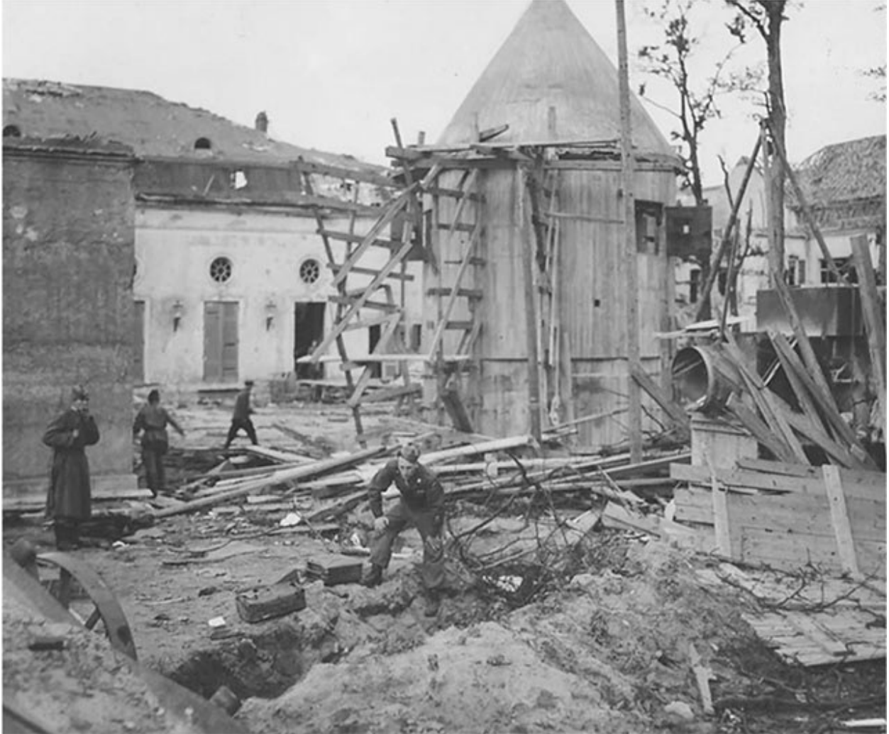
Betonowe wejście (po lewej) i wentylator bunkra Hitlera na zapleczu Nowej Kancelarii Rzeszy po upadku Berlina
