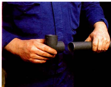
Rys. 7. Właściwe uchwycenie elementów zapobiega wypchnięciu kleju do wnętrza złączki [10, s. 18]
