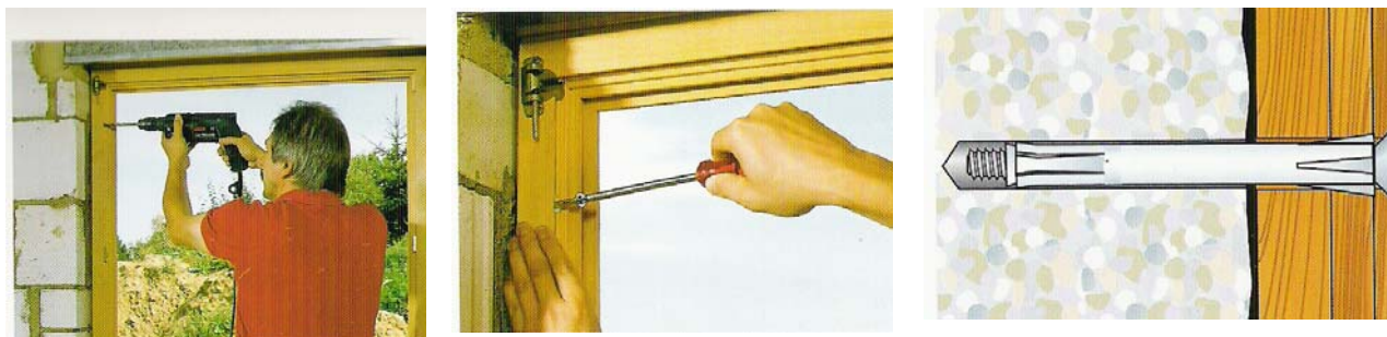
Rys. 11. Montaż ościeżnicy okiennej [1, s. 31]
