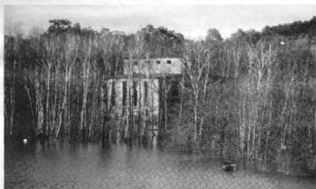
To nie osiadła w krzakach arka Noego, ale zalany wodą budynek przy kopalni "Szczygłowice".
