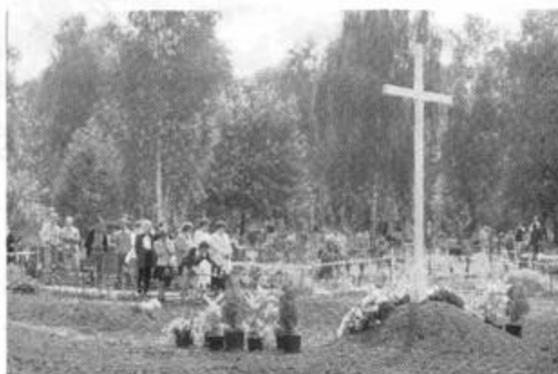
Obfite deszcze podczas powodzi w lipcu 1997 roku spowodowały osunięcie się skarpy na cmentarzu w Rybniku. Wówczas zapadły się 294 groby. W ich miejscu usypano zbiorową mogiłę.
