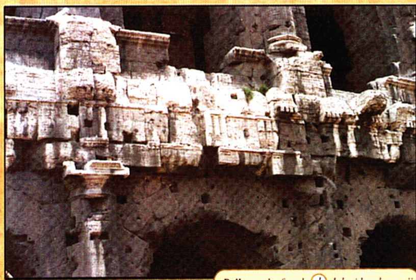
Belkowanie fasady 1 dolnej kondygnacji.
