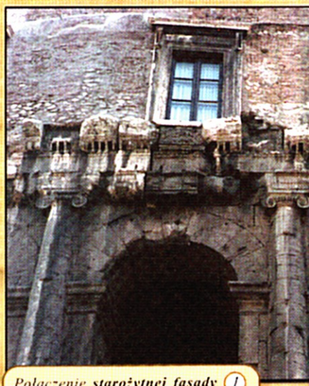
Połączenie starożytnej fasady 1 teatru z renesansową nadbudową.
