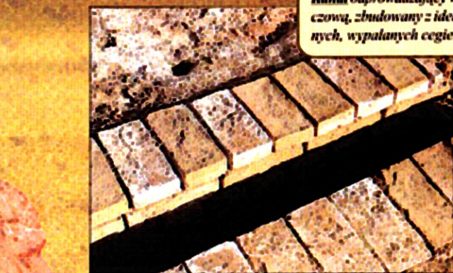
Fragment wieży ⑦.
