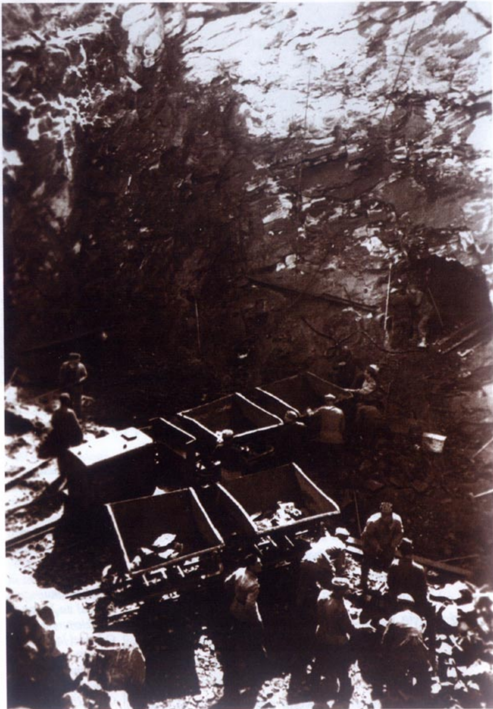
Norwescy robotnicy budują schron amunicyjny dla niemieckiej baterii artylerii przeciwlotniczej
